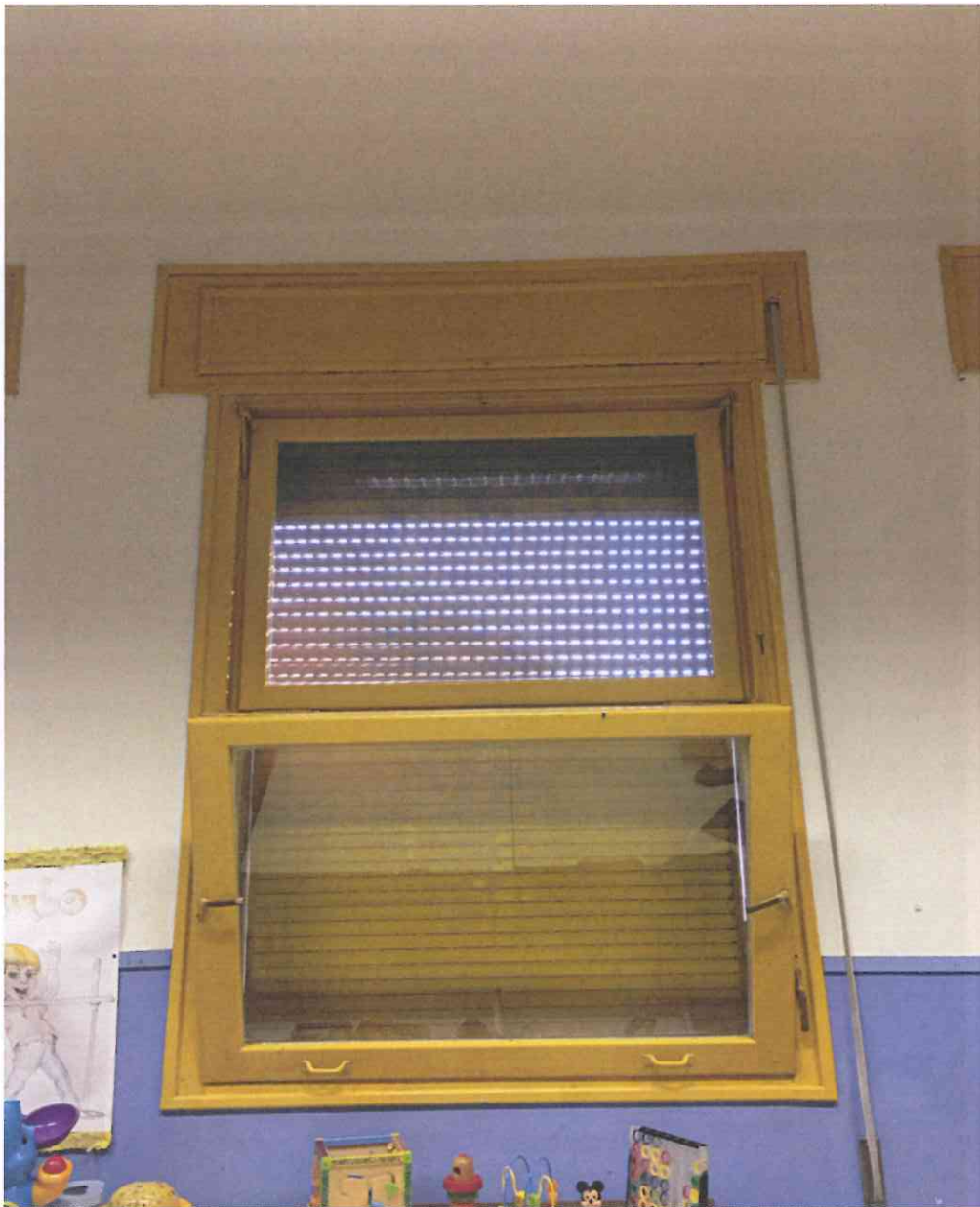
Vista della finestra delle aule didattiche con apertura a “saliscendi” e vasistas (lettera A nell'abaco dei serramenti)
