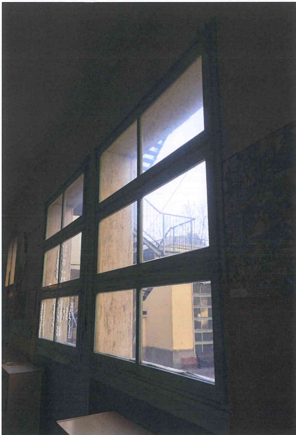
Vista della finestra del corridoio con apertura a vasistas (lettera B nell'abaco dei serramenti)
